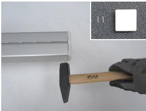
Montage Pfostenverschlusskappe quadratischer Pfosten:
