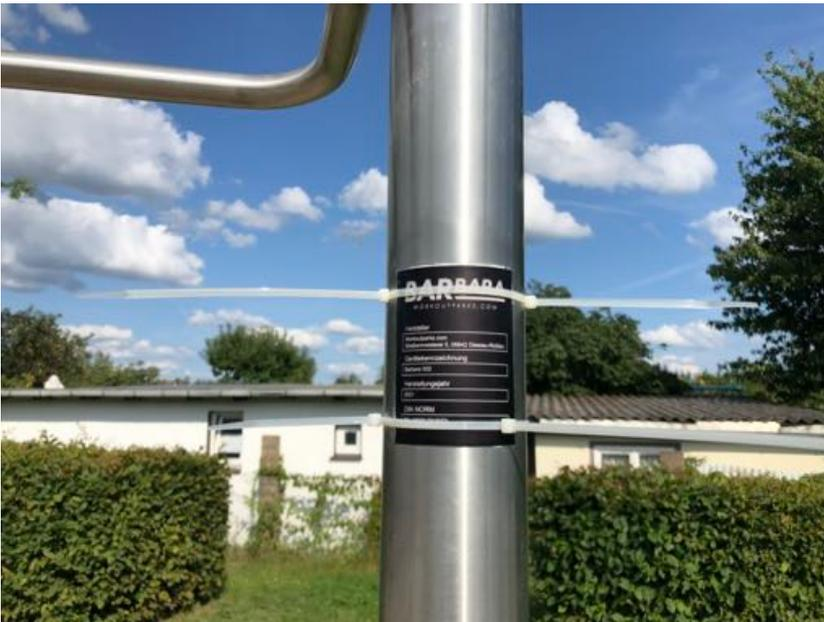
13. Hinweisschild aufstellen: Pfeiler mindestens 60cm einbetonieren, Schild mit den mitgelieferten Schellen am Pfeiler anbringen
