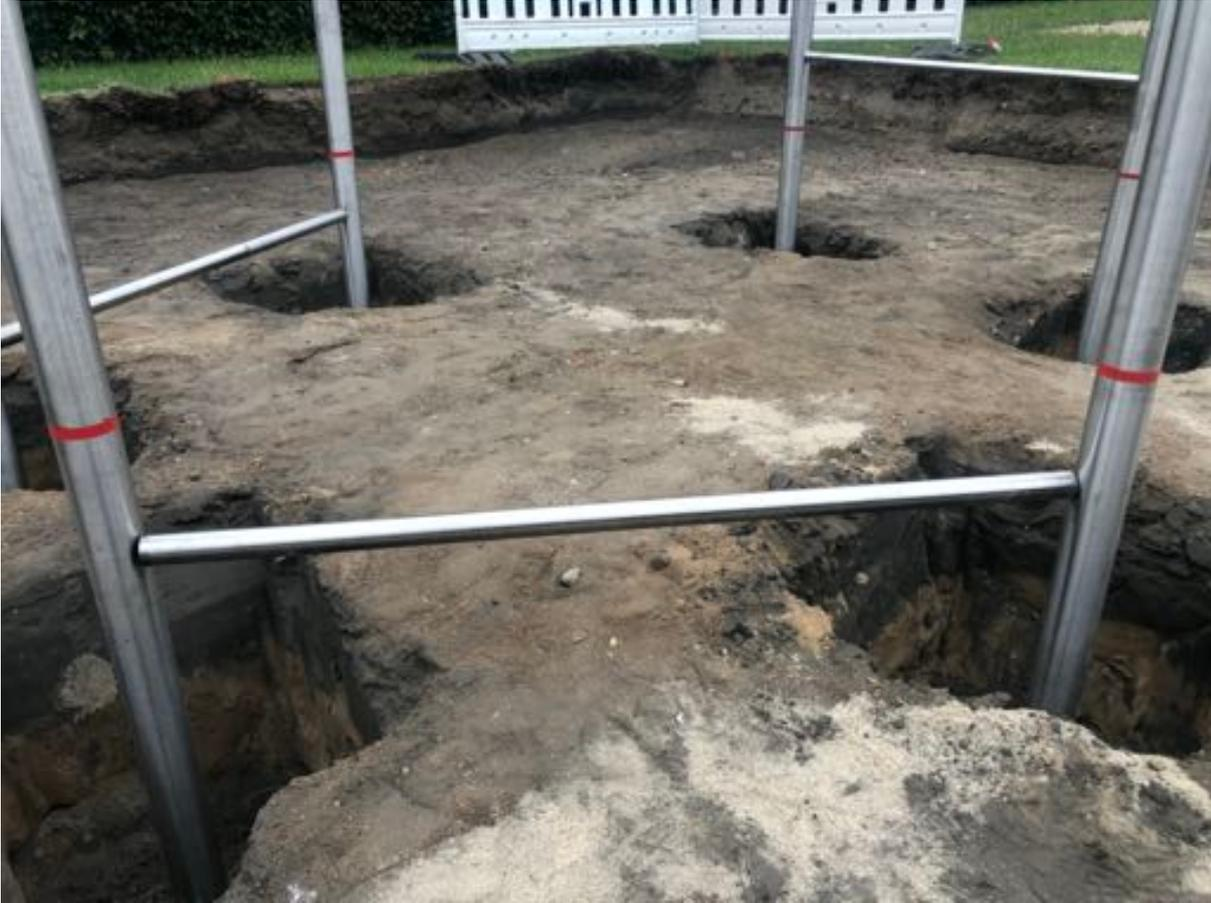
11. Entsprechenden Fallschutz installieren (dieser muss die Rote Markierung überdecken)
