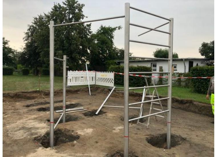
5. Im nächsten Schritt wird die Multigrip Bar aufgestellt und mit der Verbindungsstange von der Sprossenwand verschraubt.
