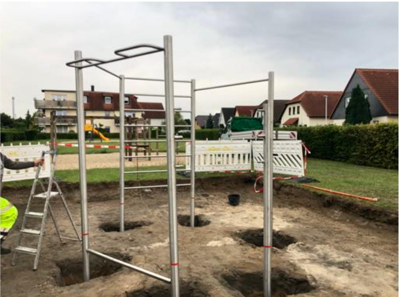
6. Die restlichen Verbindungsstangen (2x kurz, z 1x dick) werden nun zwischen Multigrip Bar und flacher Reckstange geschraubt. Dabei ist die dicke Stange in der Mitte und die Bolzen zeigen nach außen.
