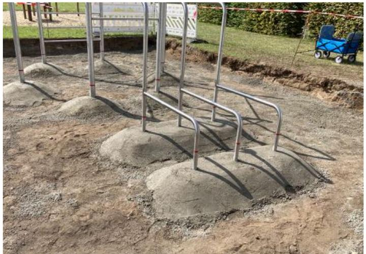
10. Entfernen der Abstandshalter mit einer Flex nachdem die Fundamente fertig sind
