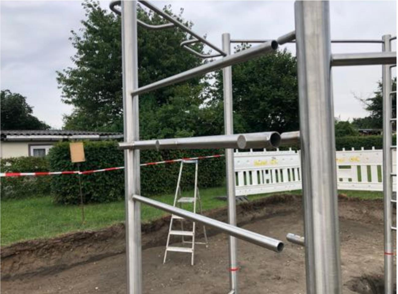
7. Die 3 Barrenstangen auf die Bolzen schieben und verschrauben
